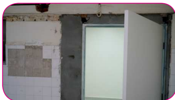
Obras em andamento
